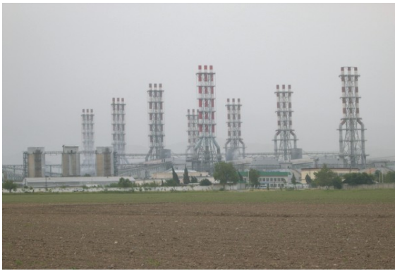
Таджикский алюминиевый завод
