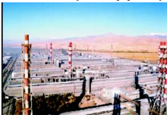
Таджикский алюминиевый завод
